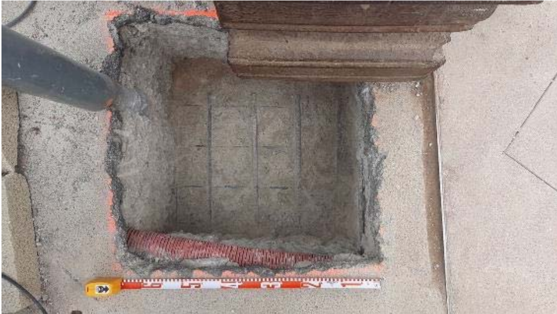
Fotografia 23: s'identifica al final de la Cala 3 la UE 725, una massa metàl·lica que permet la fixació del formigó UE 723.
