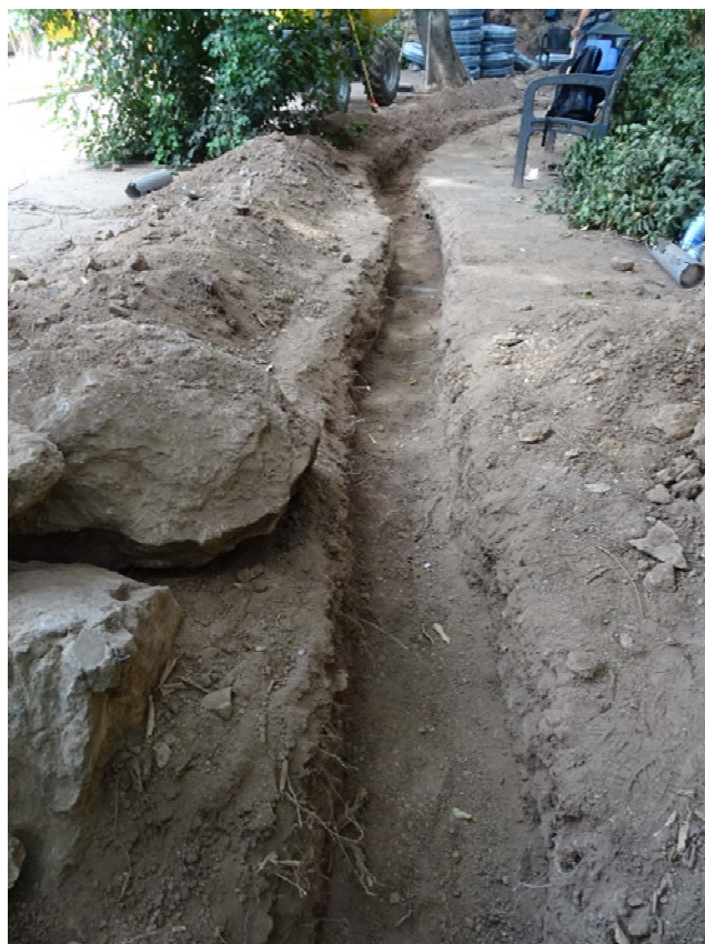
22. Tram 8. Rebaix de la rasa 1
