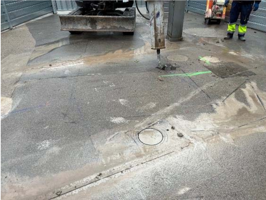
Fotografia 33: inici d'obres amb Eurocalalana a la porta del Carmel. Extracció d'UE 701.
