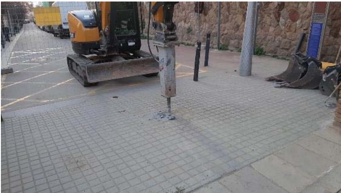
Fotografia 1: inici obres a la porta de Sant Josep. Extracció UE 100.
