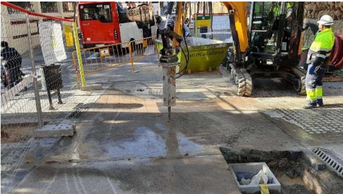
Fotografia 38: inici de les obres a la primera fase de les pilones mòbils. Extracció UE 800.
