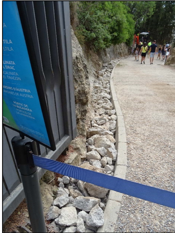
8. Inici dels treballs tram 4. Porta de Can Trias
