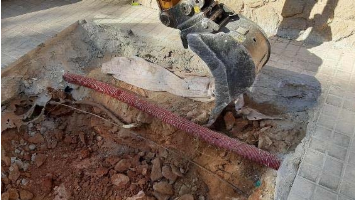
Fotografia 49: desmuntatge de part del paviment original del parc (UE 6002) situat a l'altre banda de la rasa dels tubs elèctrics.
