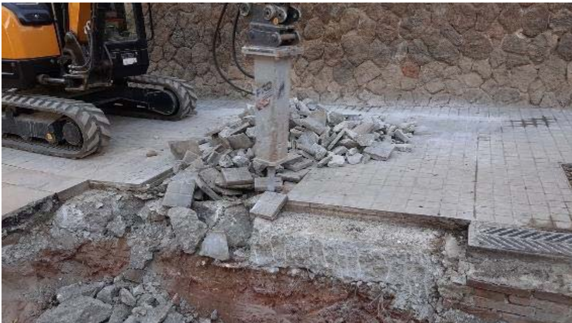
Fotografia 40: inici segona fase d'actuació de l'obra al carrer Olot. Extracció de la UE 812.
