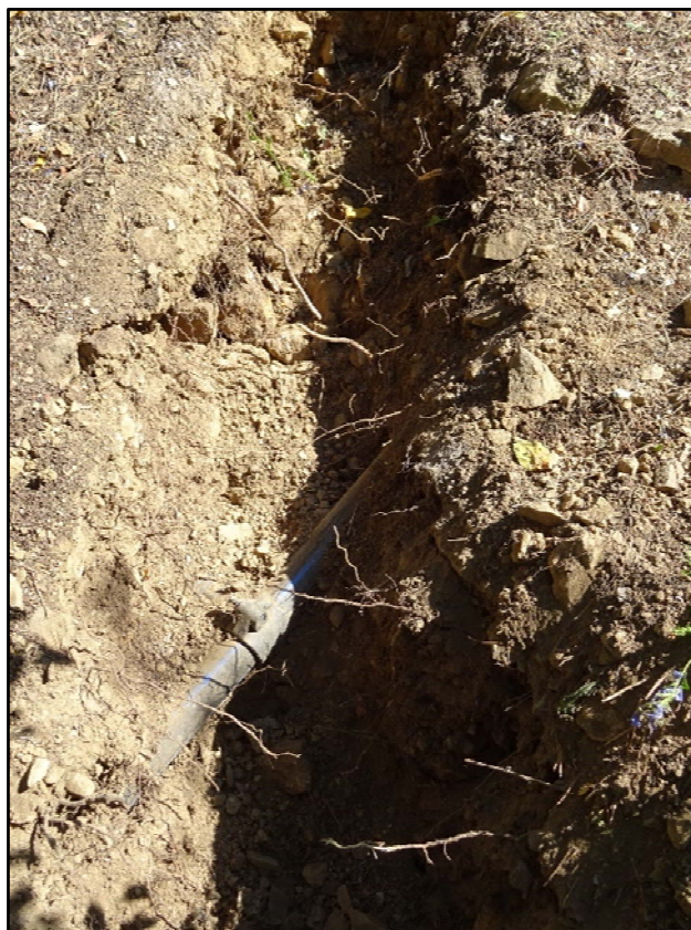
19. Tram 7. Detall de serveis i tall de la rasa
