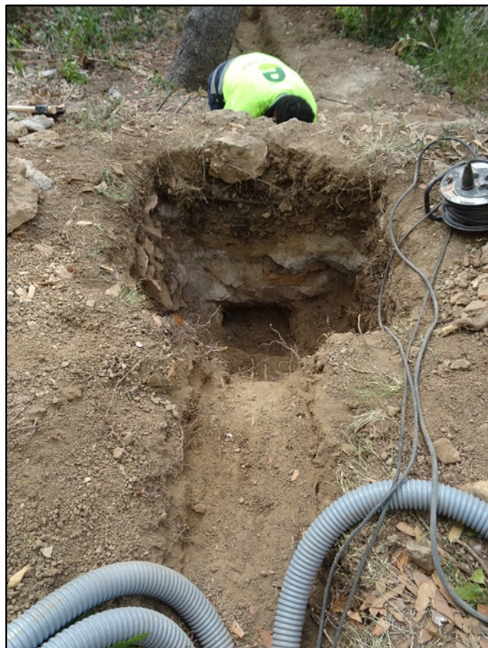
25. Tram 8. Treballs d'excavació per sota mur
