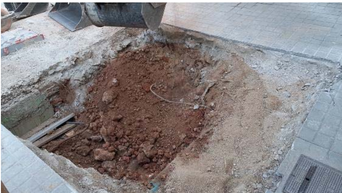
Fotografia 50: inici tercera fase d'obres al Carrer d'Olot. Extracció UE 831 i UE 830.
