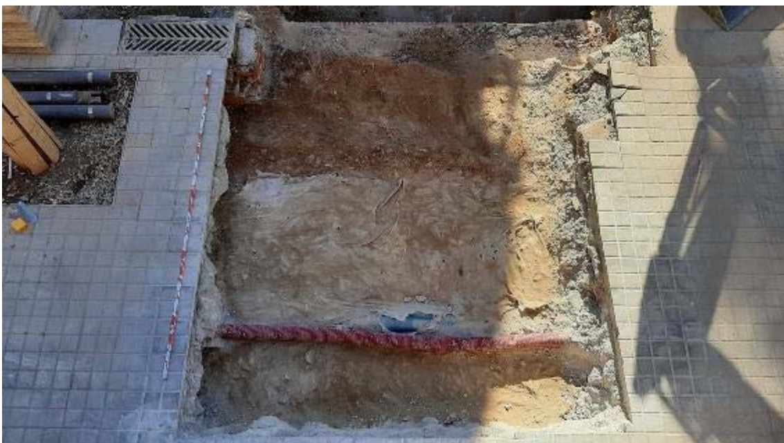
Fotografia 42: detall del cobriment amb geotèxtil del paviment de Gaudí (UE 6002).
