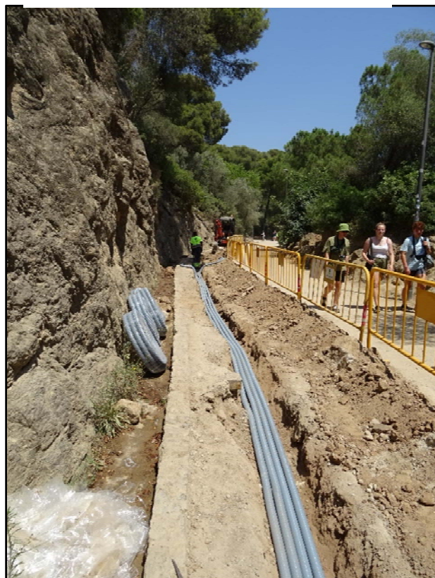
5Traçat de la rasa amb la instal·lació dels tubs
