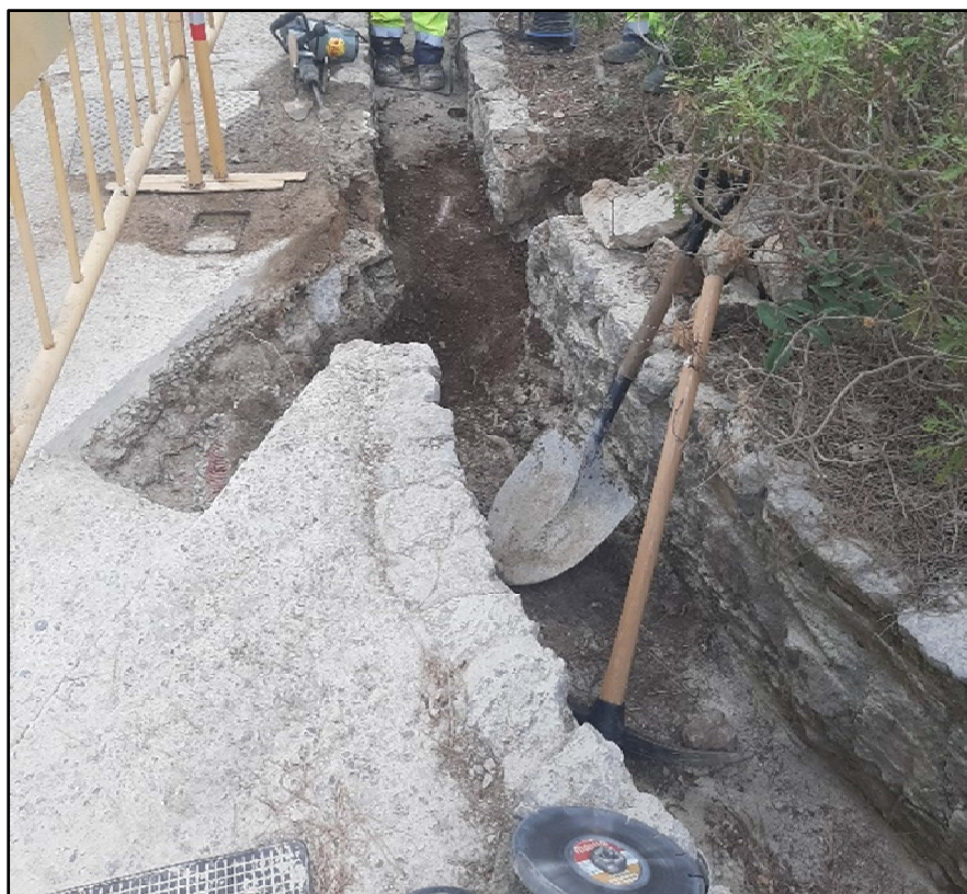
13. Tram 5. Treballs a la zona del parterre 1
