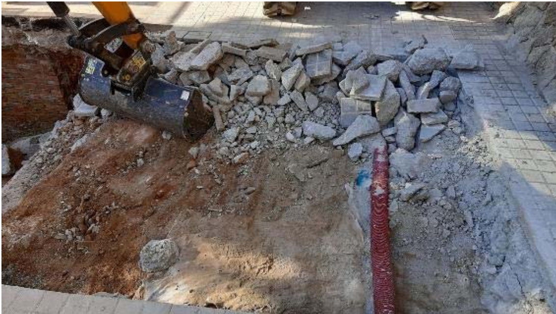
Fotografia 41: localització del paviment original de Gaudí (UE 6002), situat sota el geotèxtil. Intervenció realitzada anteriorment per l'arqueòloga Anna Bordas, amb codi de intervenció 007/13.
