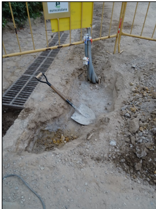
12. Arqueta del tram 5
