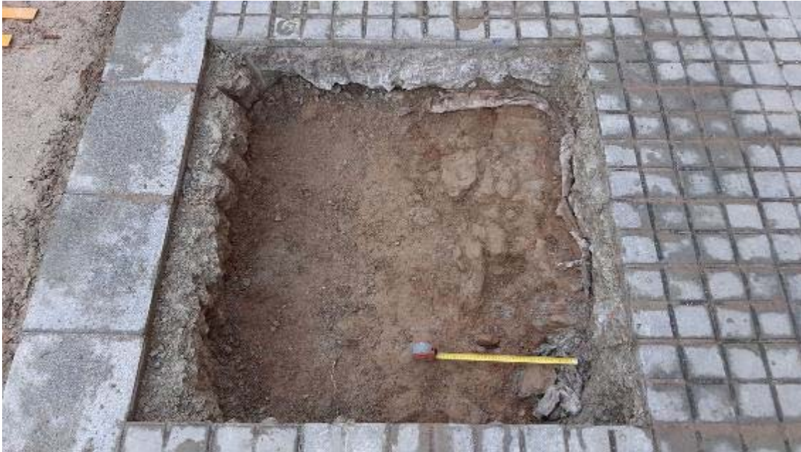
Fotografia 53: detall dels 40 centímetres de paviment (UE 6002) que es desmuntaran per a fer el forat de l'arbre.
