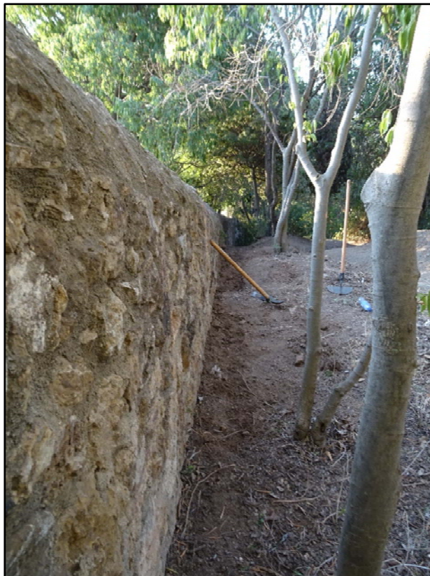
20. Tram 8. Traçat de la rasa a tocar la valla
