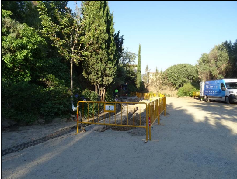
1. Inici dels treballs
