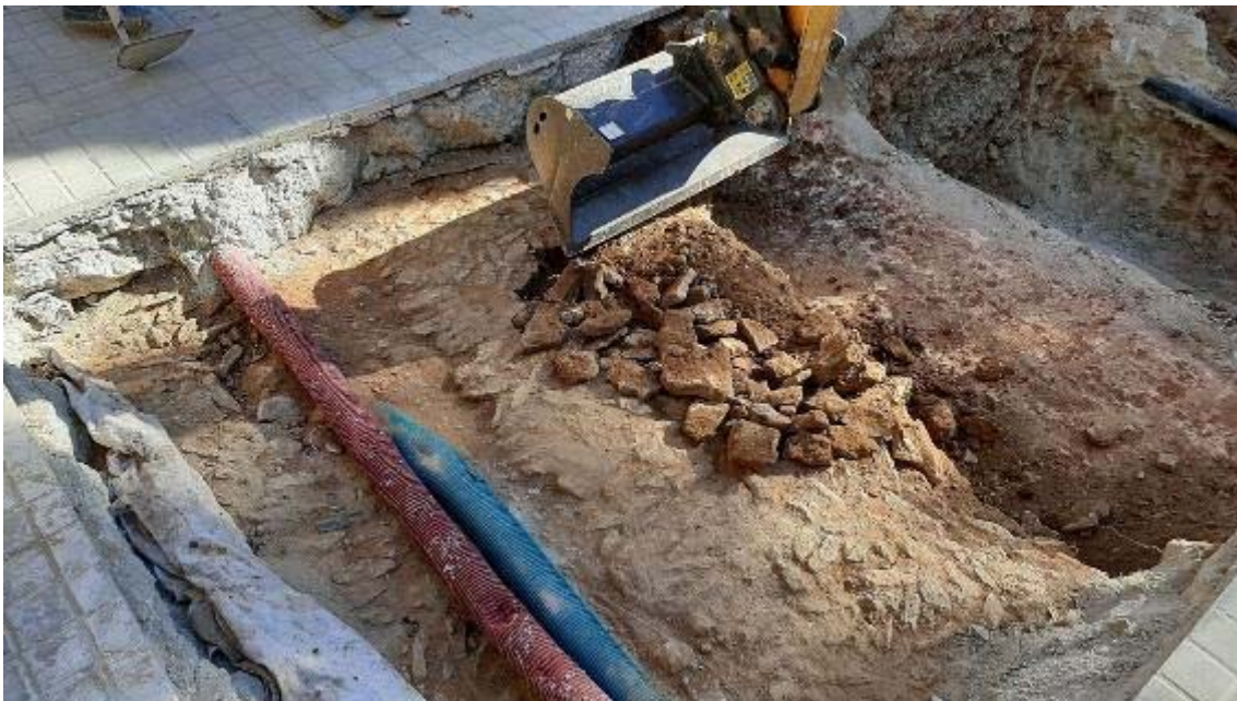
Fotografia 44: procediment de desmuntatge de la UE 6002.
