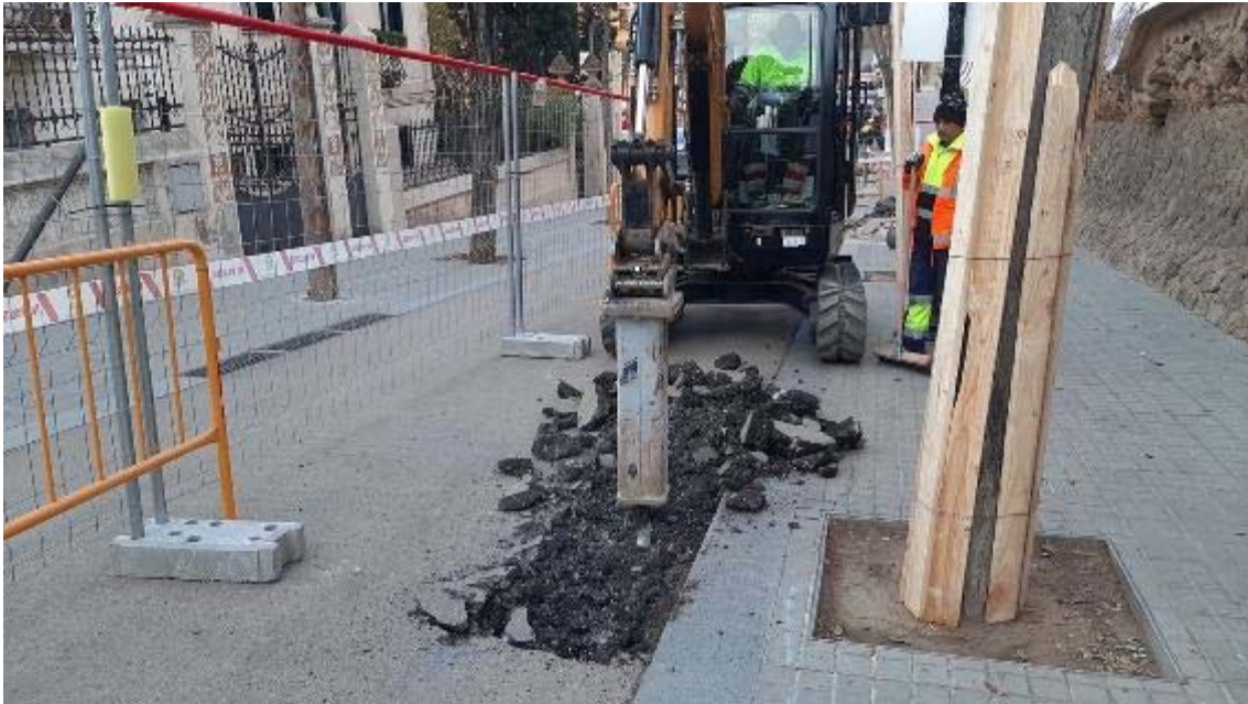
Fotografia 35: inici obres a la porta del carrer Olot. Rasa de connexió de cables per a les pilones mòbils.
