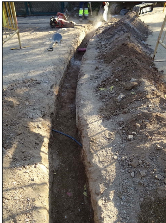
15. Tram 6. Vista de la rasa
