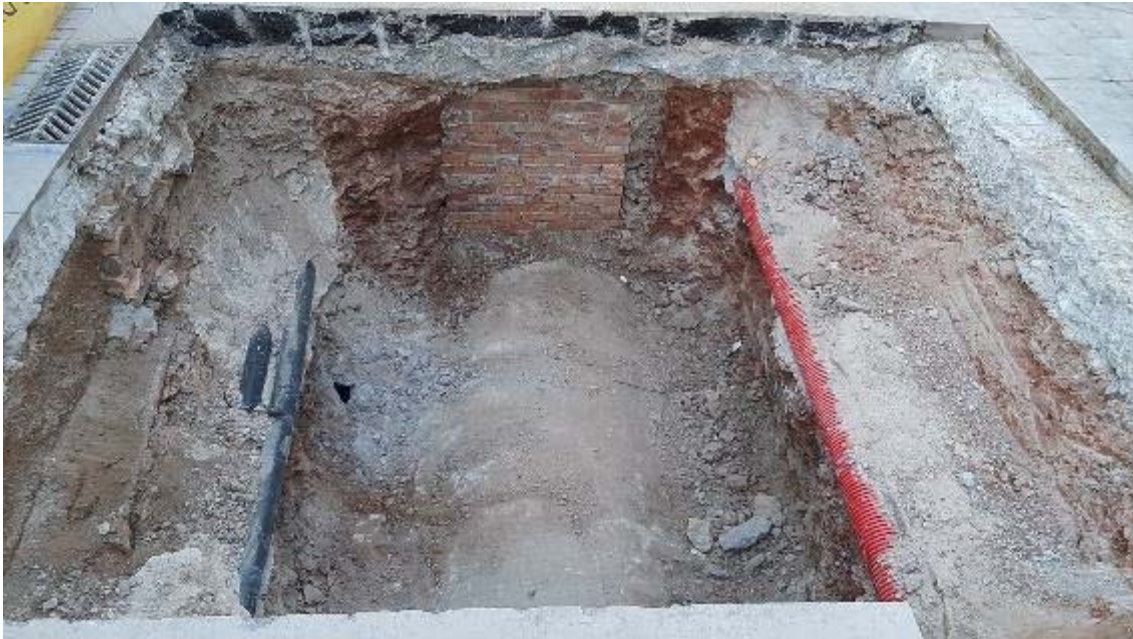
Fotografia 39: cota final de les obres per a la instal·lació de les pilones mòbils. Detall de Secció A.8.
