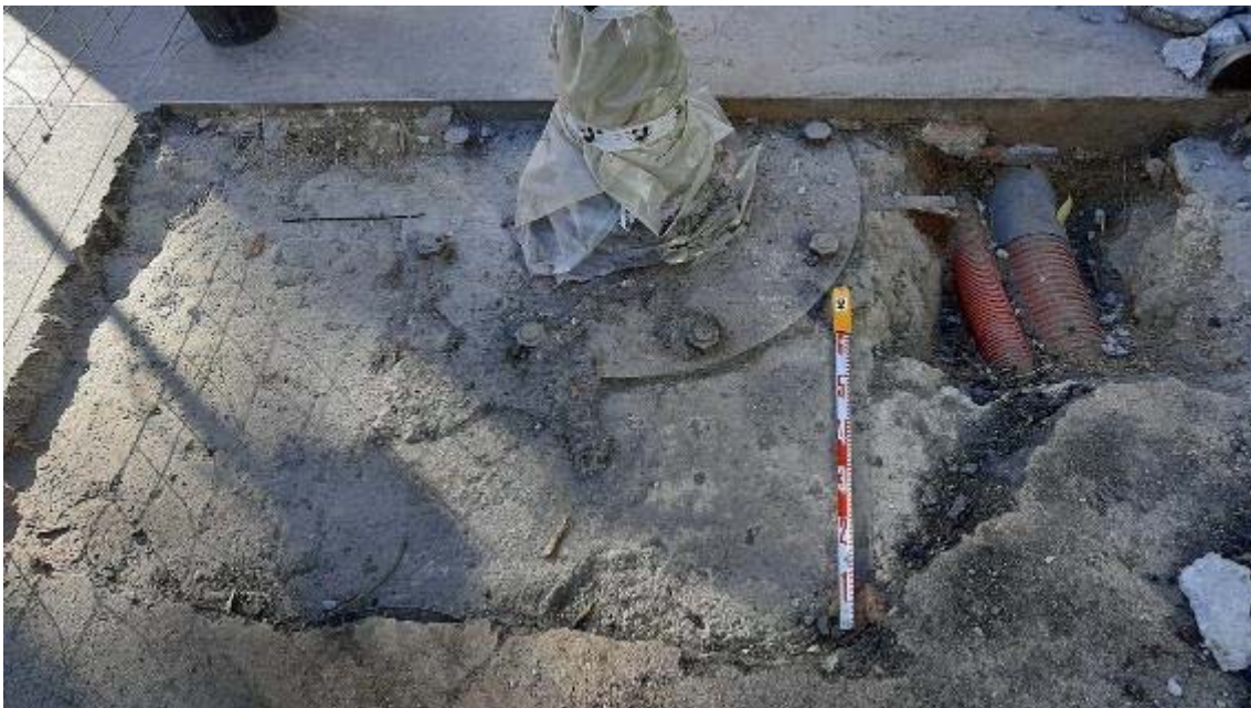
Fotografia 12: a la part exterior del parc, s'identifica la base de l'eix de la porta (UE 705), feta de formigó, amb el retall lateral dels tubs elèctrics (UE 714).
