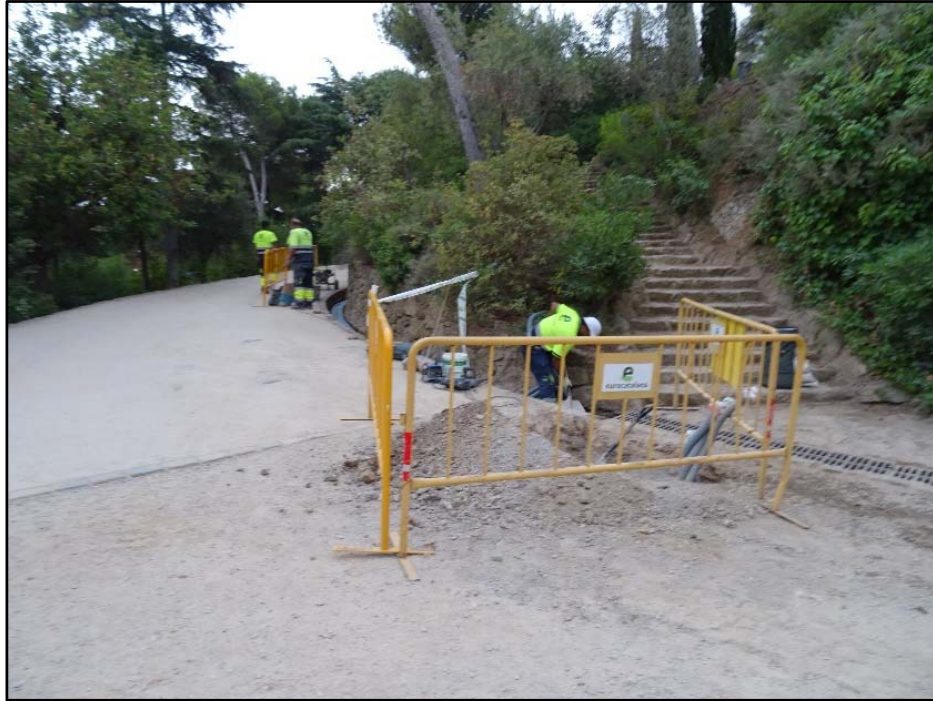
10. Inici dels treballs
