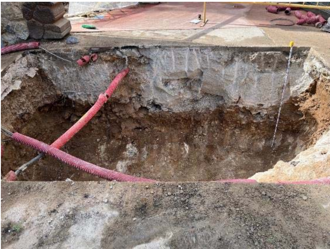
Fotografia 34: fotografia de detall de secció A.7.
