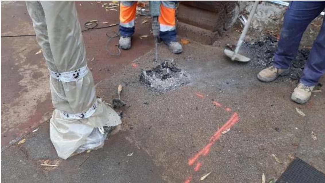
Fotografia 11: inici obres. Extracció UE 701.
