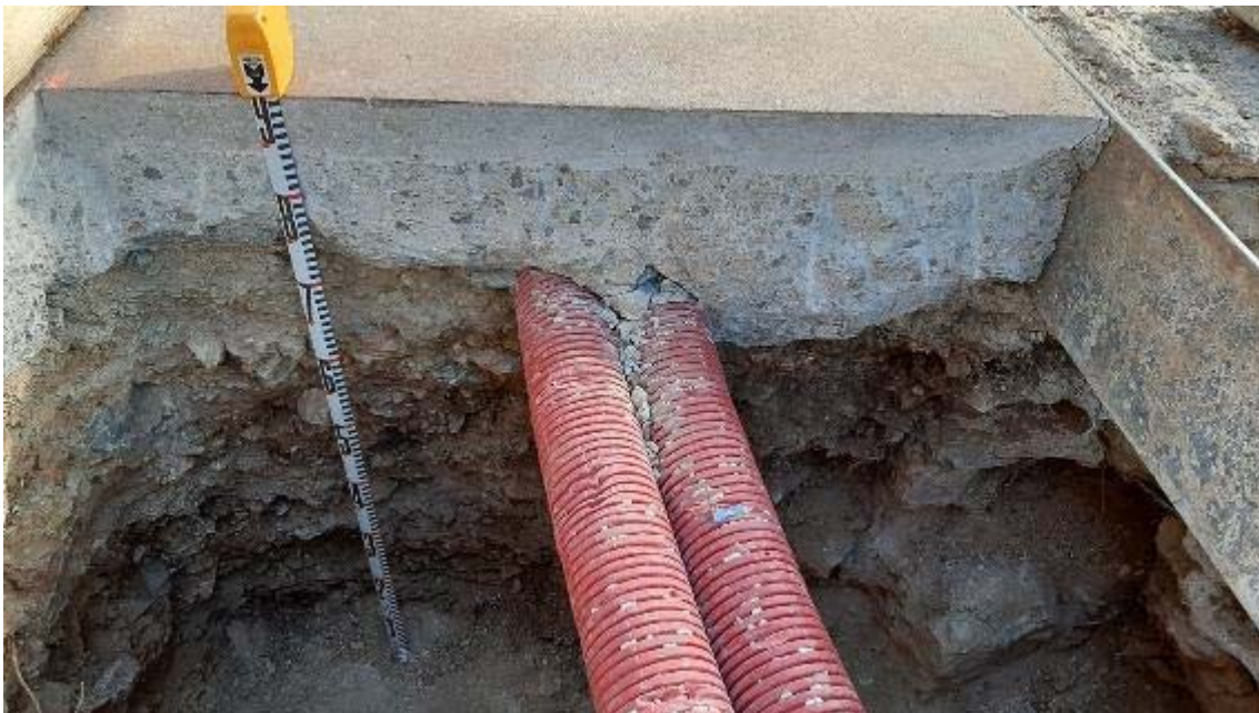
Fotografia 32: detall de secció del Rebaix 4.
