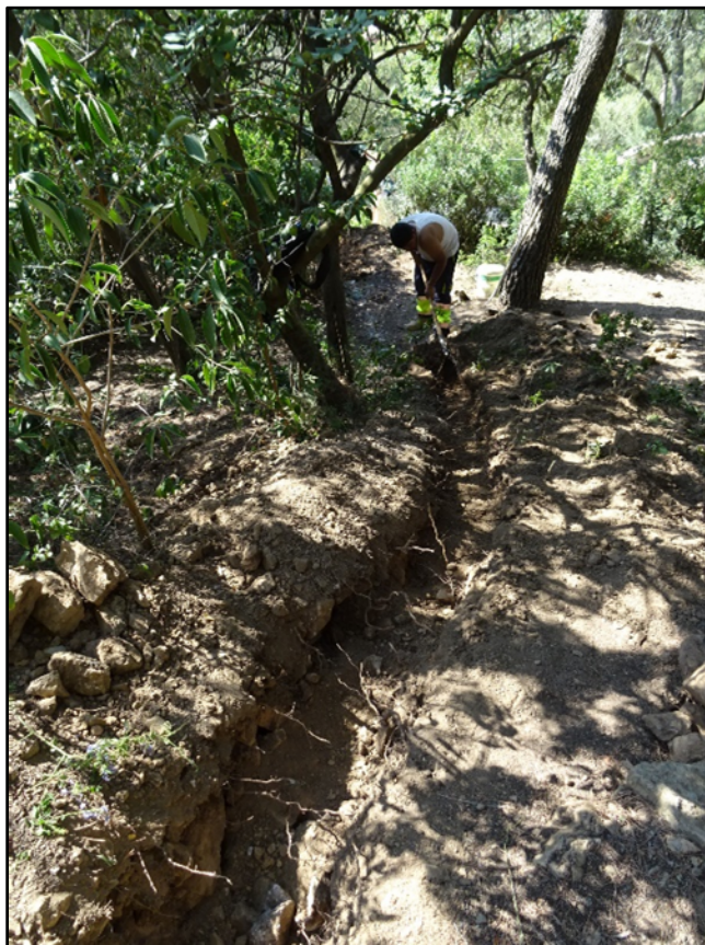
18. Tram 7. Treballs de rebaix. 1
