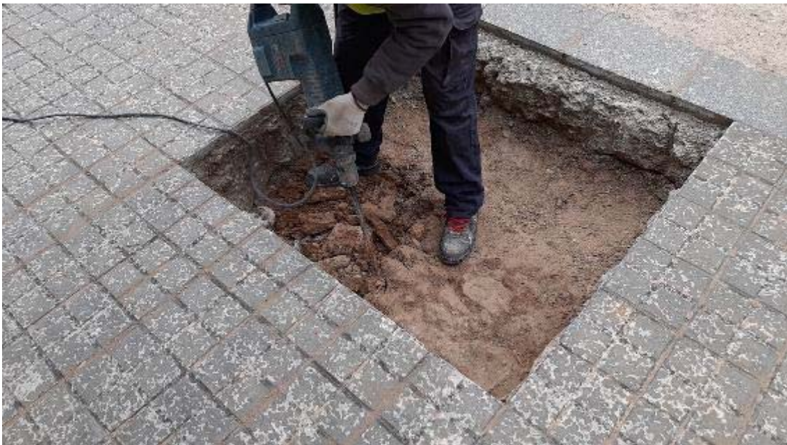
Fotografia 54: desmuntatge de pavimentació UE 6002.
