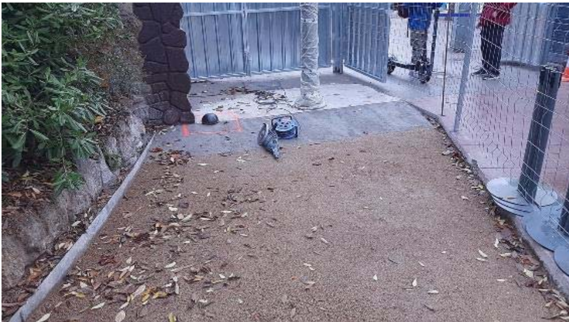
Fotografia 16: localització del topall de la porta. Detall de la Cala 1.
