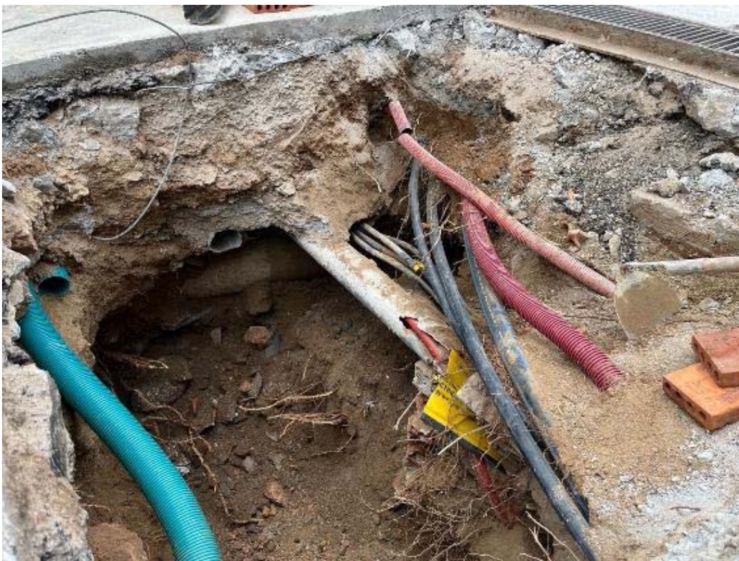
Fotografia 58: cota final de les obres a la porta Monumental del carrer Olot. Rebliment UE 902 de sauló dels diversos tubs.
