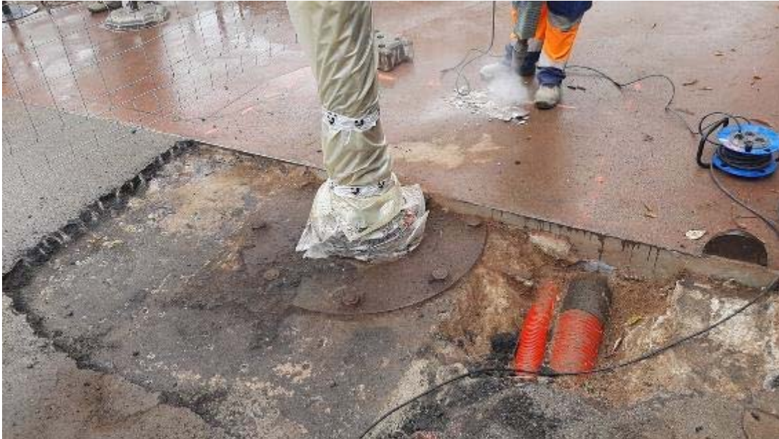
Fotografia 13: inici de les obres a la part interior del parc, per a la localització de la base de formigó de l'eix (UE 705).
