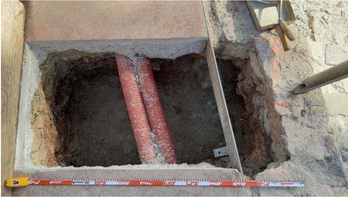
Fotografia 31: detall del Rebaix 4 finalitzat.
