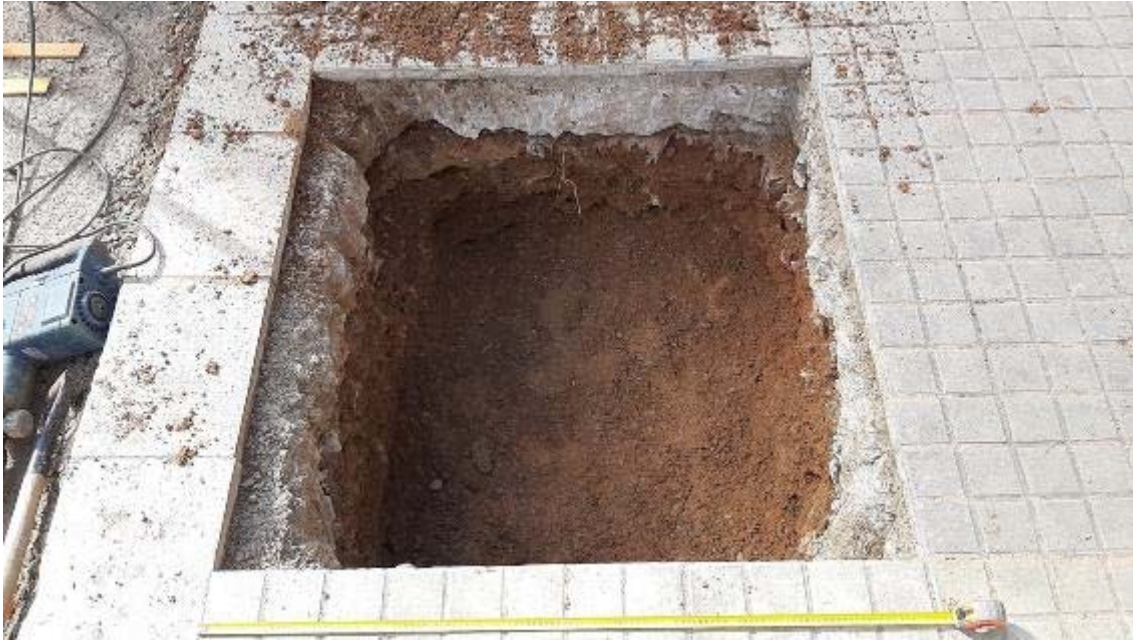
Fotografia 55: finalització del nou rebaix per a la implantació d'un arbre.
