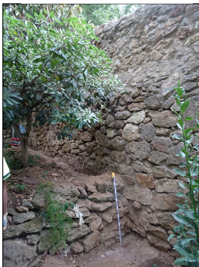
23. Tram 8. Zona dels murs de les terrasses
