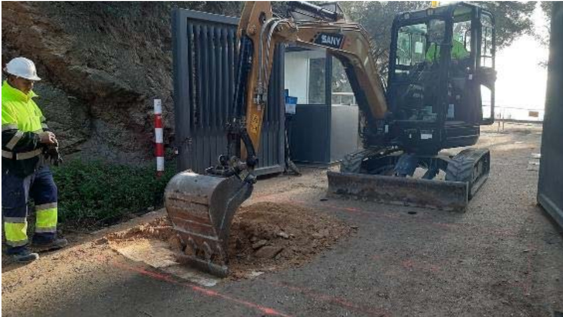
Fotografia 5: inici rebaix porta Forat del Vent. Extracció UE 400.
