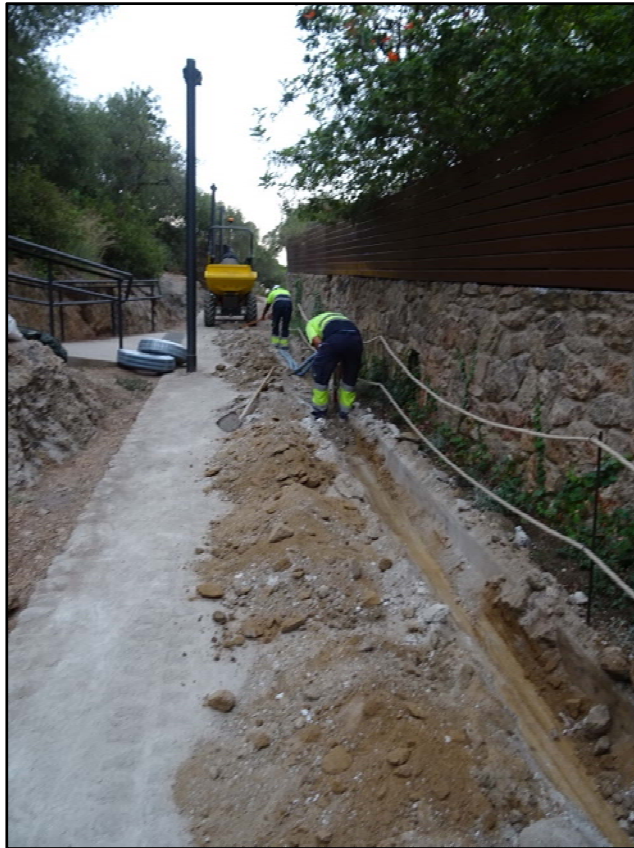
14. Tram 6. Treballs a la zona d'accés al Calvari
